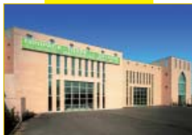
Plant n° 3 - Steel works - OSIO SOTTO
